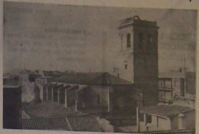
Vista del campanario y de la cúpula de la iglesia de la Asunción
